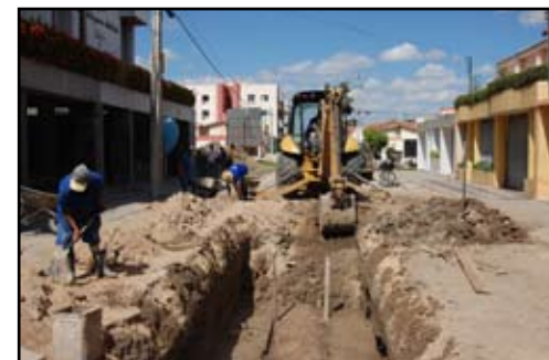
Obras receberão investimentos da ordem de R$ 22 milhões
